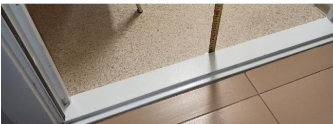
Примеры дверей с завышенным порогом. Фото 3.06. Кабинет администрации. Высота порога - 0,02 м
