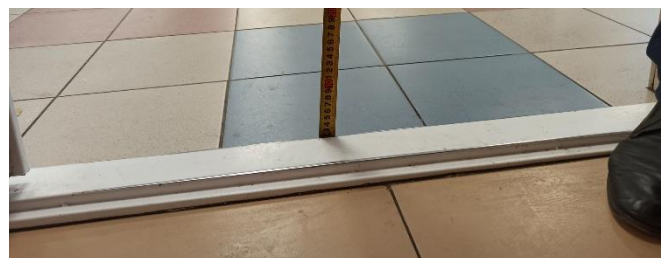
Фото 3.07 Дверь в столовую. Высота порога - 0,025 м
