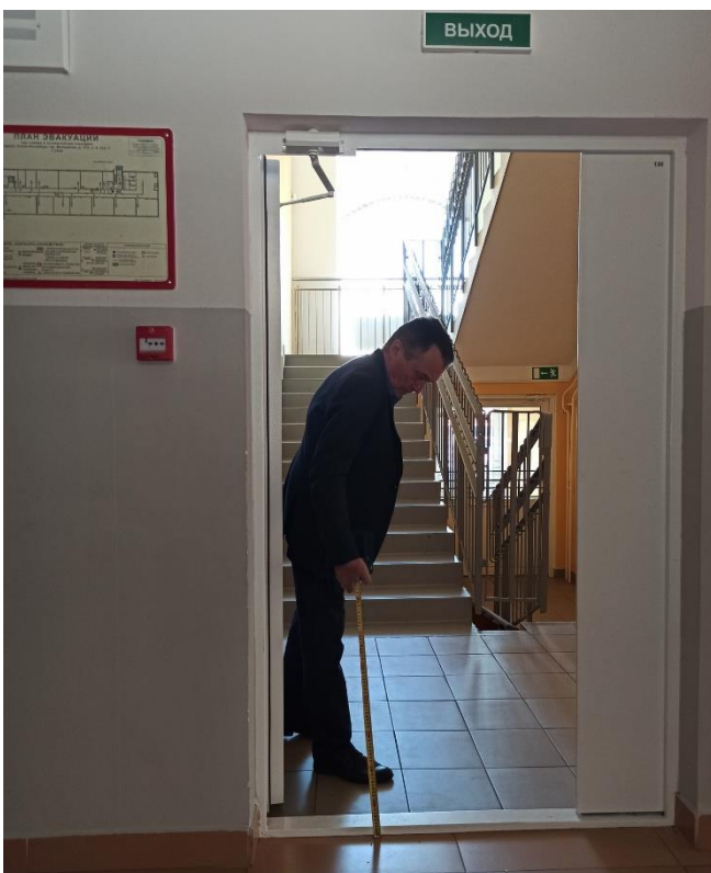
Фото 3.08. Дверь на лестничную клетку. Порог - 0,03 м
