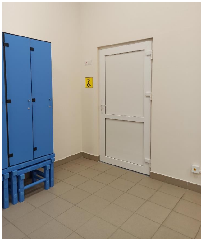
Фото 5.05 - 5.08. Санузлы для МГН с душем в раздевальных бассейна. Ширина дверного проема - 0,90 м. Оборудование не соответствует требованиям для инвалидов на креслах-колясках и других МГН.
