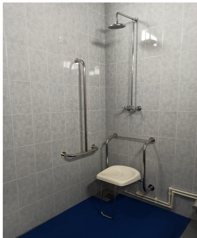
Фото 5.05 - 5.08. Санузлы для МГН с душем в раздевальных бассейна. Ширина дверного проема - 0,90 м. Оборудование не соответствует требованиям для инвалидов на креслах-колясках и других МГН.
