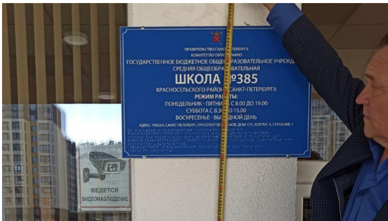
Фото 2.03. Вывеска тактильно - визуальная на входе. Нижний край вывески на высоте 1,50 м от поверхности площадки.
