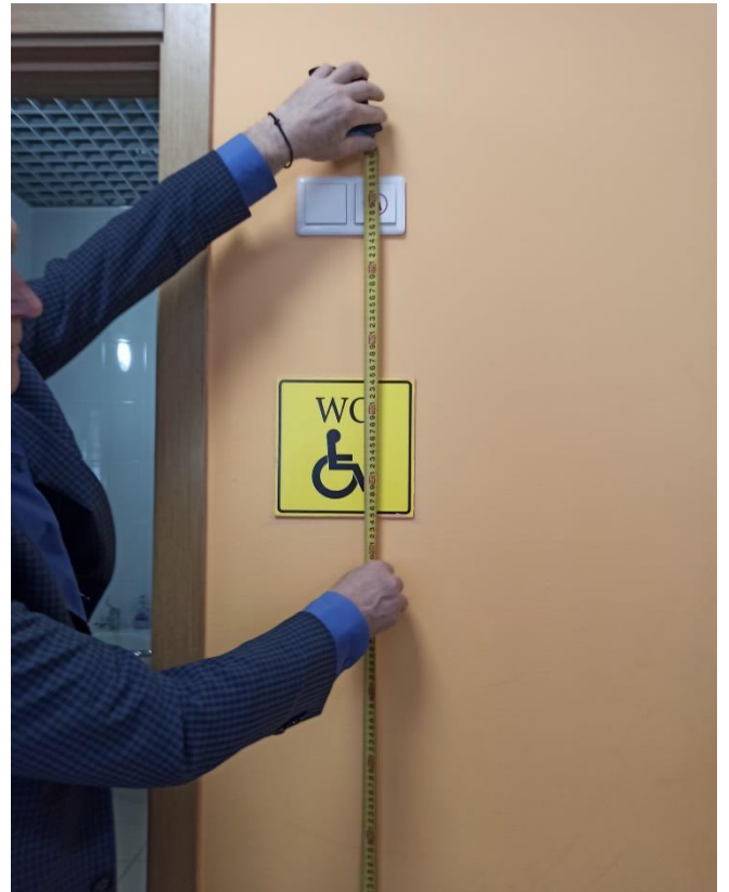
Фото 5.02. Высота электрического выключателя - 1,80 м не соответствует требованиям доступности для инвалидов на креслах-колясках
