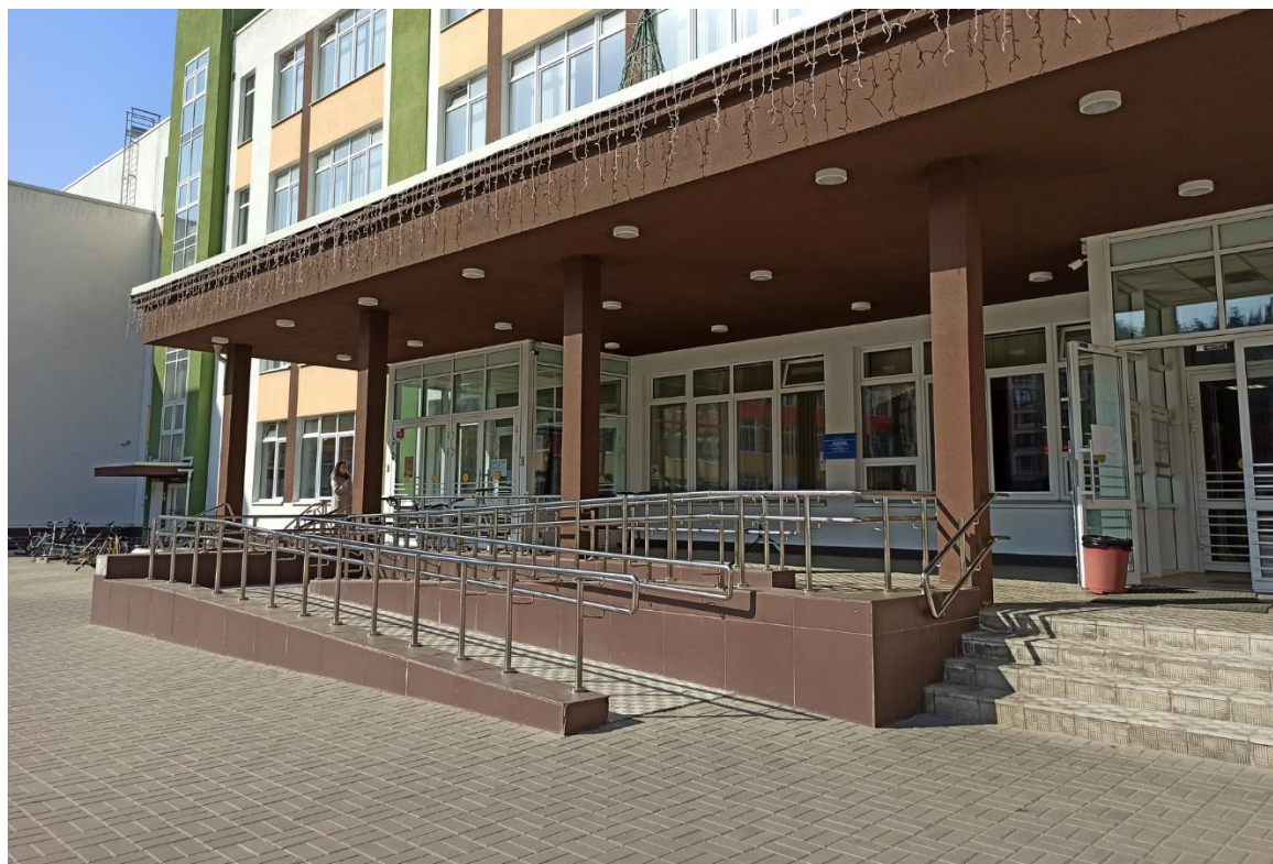
Фото 2.01. Главный вход. Пандус наружный. Уклон пандуса 4-5 %. Ширина - 0,94 м
