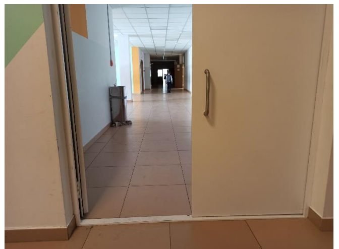
Фото 3.09. Коридор. Высота порога - 0,015 м
