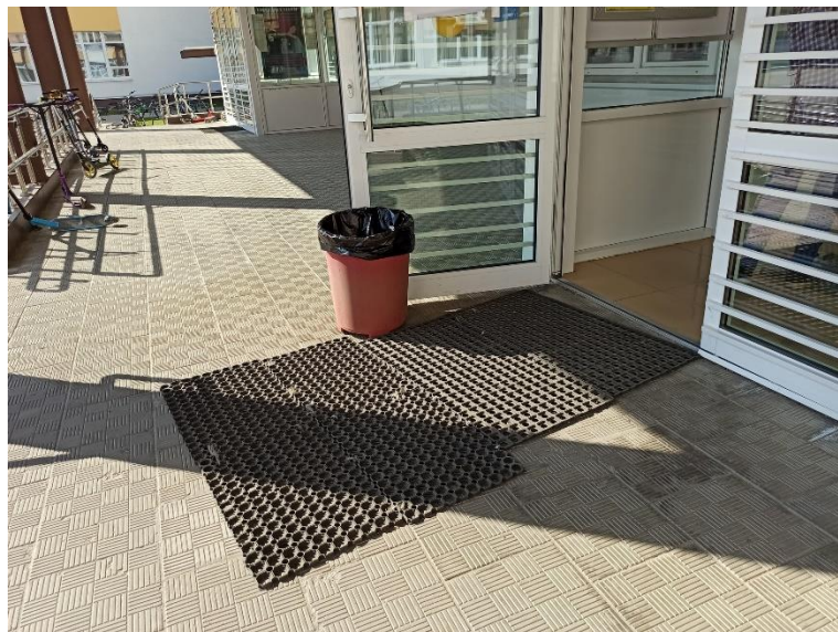
Фото 2.04 - 2.06. Наружные двери и внутренние двери тамбура. Высота порога - 0,01 - 0,015 м, ширина проема (одна створка) - 0,90 м.
