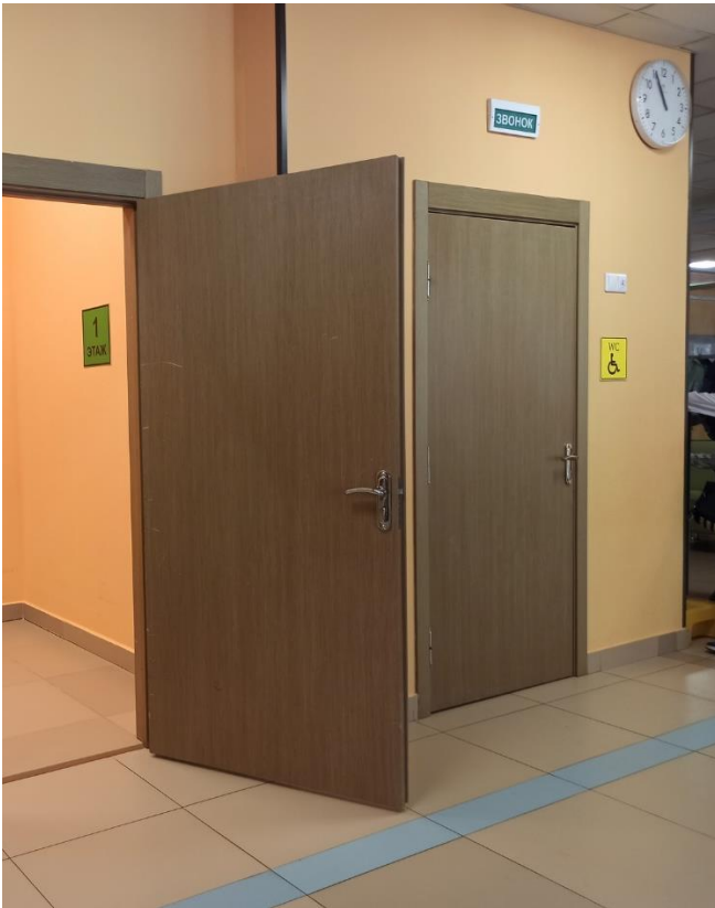
Фото 5.01. Универсальные санузлы для МГН в коридорах. Ширина дверного проема - 0,87 м.
